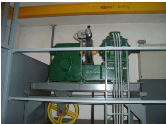
Strojovna výtahu – stroj S4 na roštu s kladkou
