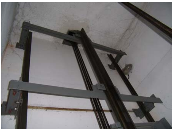
Kotvení vodiček v hlavě šachty
